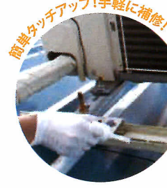
エアコン室外機標準色でタッチアップ補修 ※サビがひどい場合は事前にサビキラーPROを塗布することでより防錆効果は高くなります。
