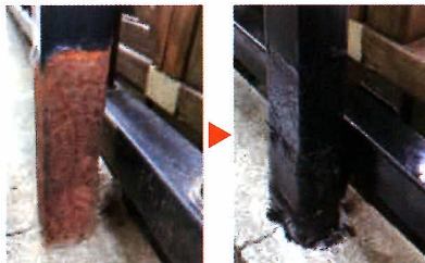
①下塗り(サビキラーPRO)→②補修(バンジエイド) →③上塗り(サビキラーカラー)
