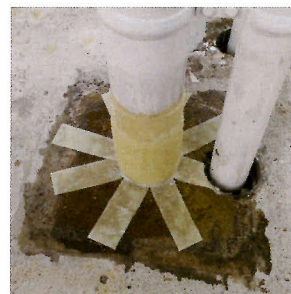
▲サビキラー-PRO RSをコンクリート面に塗布。これによりBAN-ZI AID(紫外線硬化型補修シート)の密着を向上可能。
